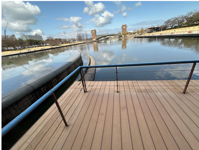
▲ 設置予定地点。園内の噴水付近、水辺側ウッドデッキ上。
